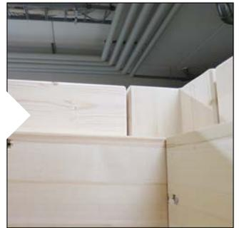
5. Montieren Sie die Deckenelemente. Schrauben Sie nur das erste und das letzte Element an. Montieren Sie die letzte Blendleiste vorne.
